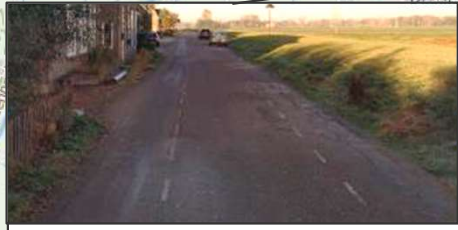
Fietspad over in parallelweg
